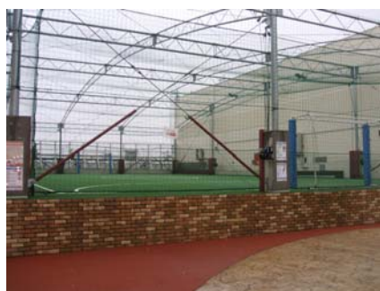
屋上のフットサルコート (屋上も収益を上げる床に)
